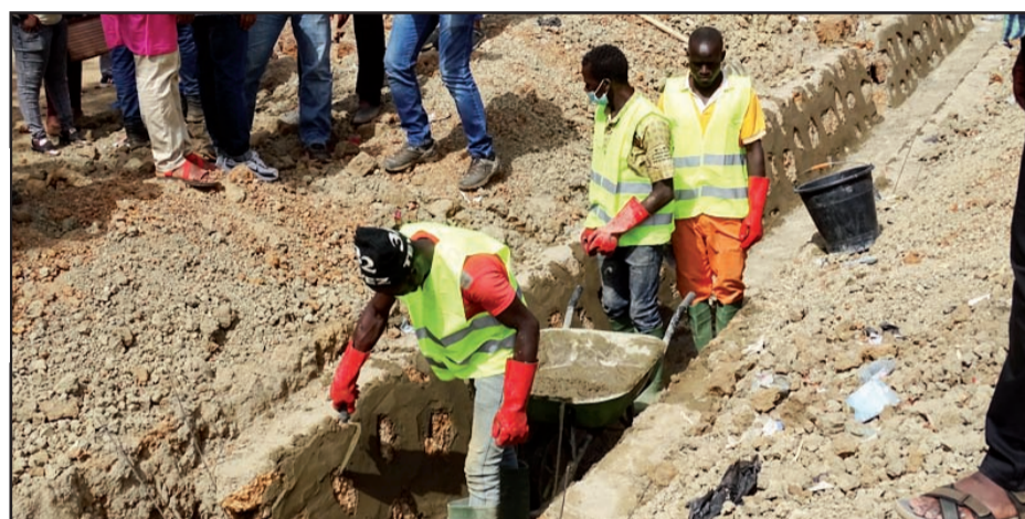
... est allée s'enquérir de l'état d'avancement des travaux d'aménagement de canaux
