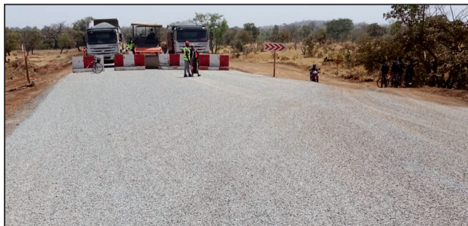
La fin des travaux de la route Manga-Zabré a été annoncée...
